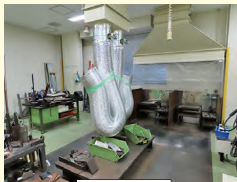
ダクト設置後
